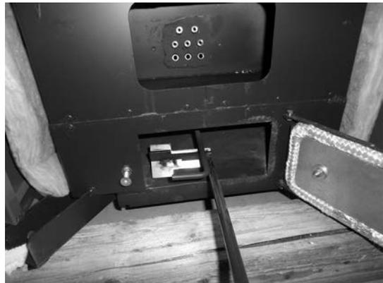
Le pousser et le redresser à l'intérieur de la chambre de combustion.
