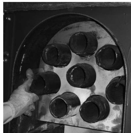
Remettre en place les turbulateurs dans les tubes échangeurs et fermer la porte supérieure
