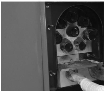
Aspirer l'intérieur de la chaudière et les tubes (autour et à l'intérieur) avec un aspirateur spécifique ou en utilisant un caisson dédié s'adaptant sur votre aspirateur domestique et résistant à la chaleur.
