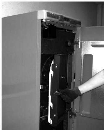
Mettre des gants de protection à la chaleur. Retirer les turbulateurs des tubes échangeurs.
